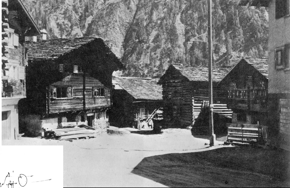
Abb.26, Strickvorschub, abgestützt auf Konsolen, die in Voluten enden, an Haus Nr.69, datiert 1746.
