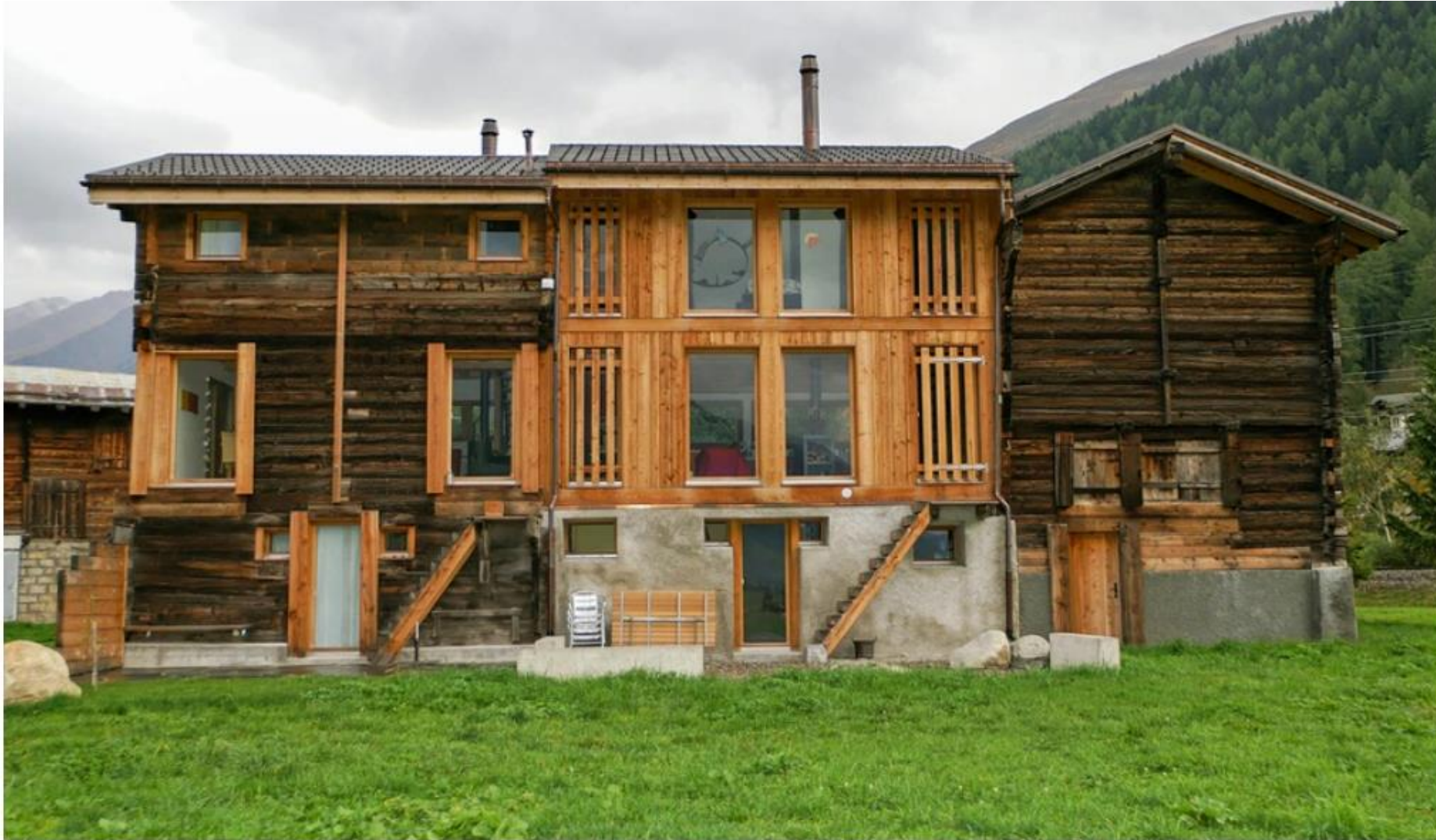
▲ Dieses alte Ökonomiegebäude im Wallis wurde in ein Ferienhaus umgebaut. Hallenbarter AG
