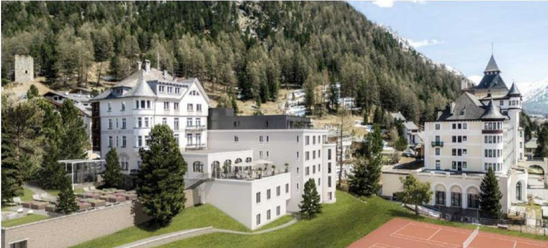
Saniertes, historisches Hotel mit projektiertem Anbau (Fotomontage); Quelle: Costa Immobilien
